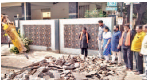
పనులను పరిశీలిస్తున్న కార్పొరేటర్ పాపనీ వినయకుమార్
